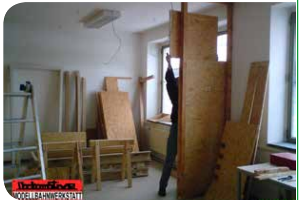
Umbauarbeiten im LOM
